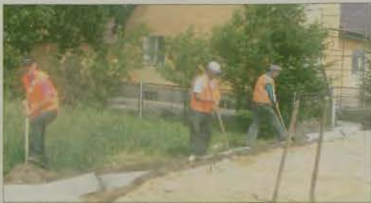
W KOTLINIE trwa budowa chodnika wzdłuż ulicy Kosińskiego
