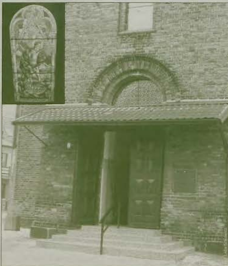
WITRAŻ ZOSTAŁ zamontowany na frontonie kościoła, tuż nad wejściem głównym
