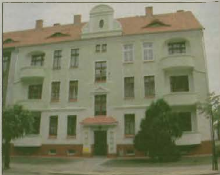
JAROCIŃSKA SPÓŁDZIELNIA odnowiła kolejny blok przy ul. Kościuszki w Jarocinie
