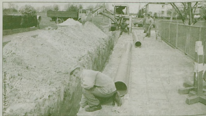
W MAJU ZAKOŃCZONA ma zostać budowa nawierzchni na części ulicy Tuwima
