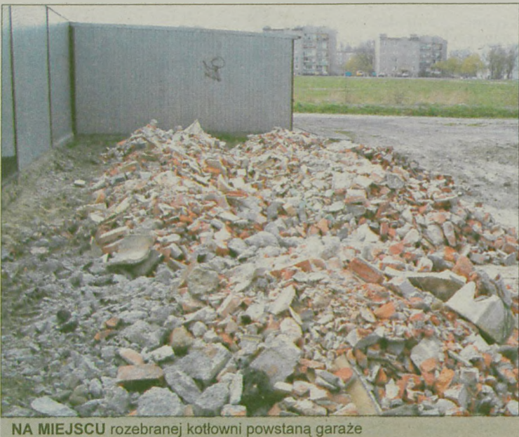
NA MIEJSCU rozebranej kotłowni powstaną garaże
