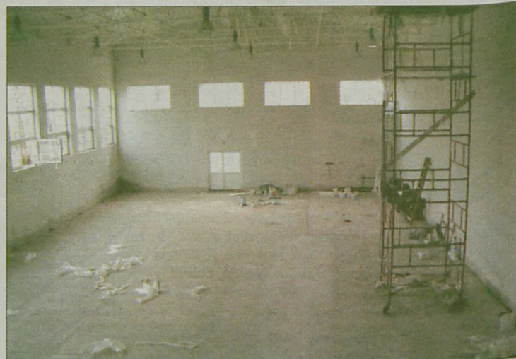
BUDOWA SALI GIMNASTYCZNEJ w Golinie pochłonie około 700 tys. zł
