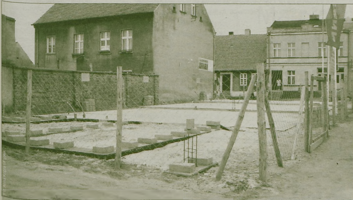
Z UZYSKANEJ DOTACJI wybudowany zostanie m.in. ośrodek informacji turystycznej z toaletami publicznymi, na rynku. Prace już się rozpoczęły, a zakończyć mają się w lecie
