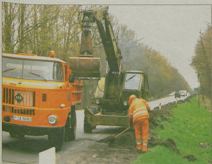
W UBIEGŁYM TYGODNIU prowadzono roboty na odcinku Mieszków - Jarocin
