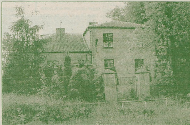
Budynek szkoły w Potworowie
