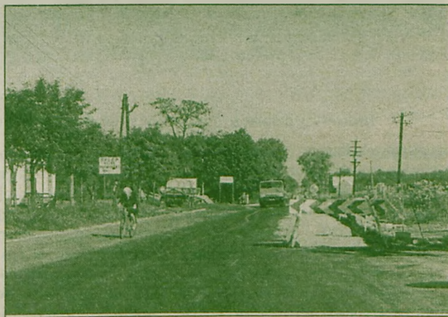
Remontowana droga nr 472 w Dobrej
