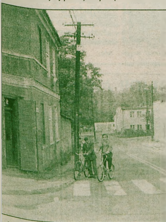
Najbardziej zniszczona jest nawierzchnia drogi w Dobrej 7 lutego 1999 r.
