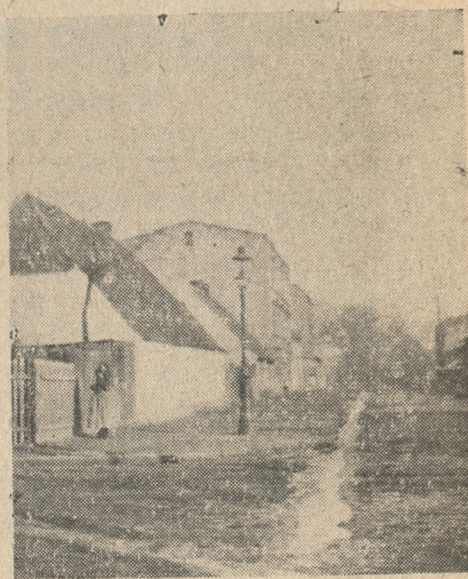
Na ulicy Średniej widać przepelnione ściekami rynsztok.
