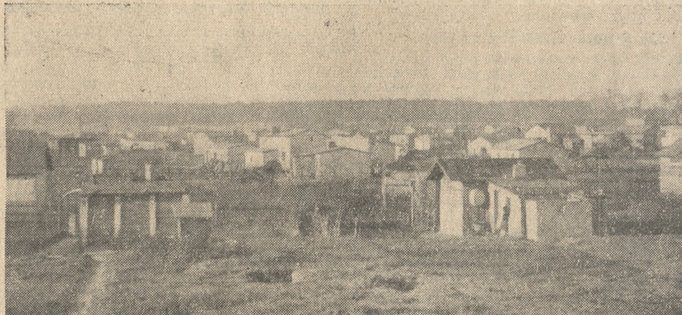
Ogólny rzut oka na osiedle przy Alei Bałtyckiej.
