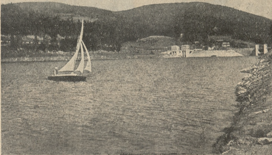
Widok ogólny na zaporę i jezioro w Porąbce.
