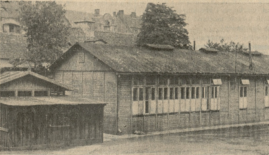
Jedna z poznańskich szkół powszechnych mieści się w baraku w bezpośrednim sąsiedztwie nieskanalizowanego ustępu.
