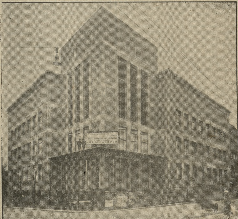
Budujący się obecnie Dom Oświatowy T. C. L. w Katowicach.
