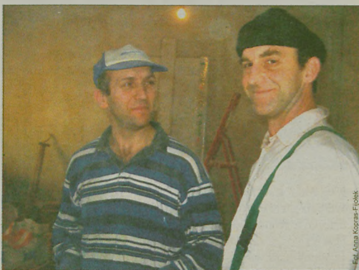
PIOTR PANTOFEL I JAN KORCZ z Komorza, zatrudnieni w ramach robót publicznych, wykonują prace remontowe w żerkowskim urzędzie
