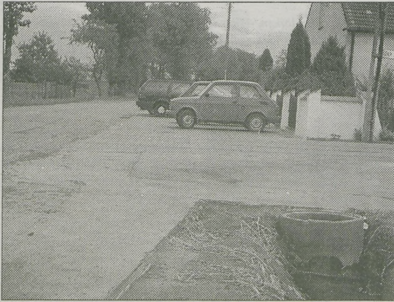
Część parkingu już została zbudowana
