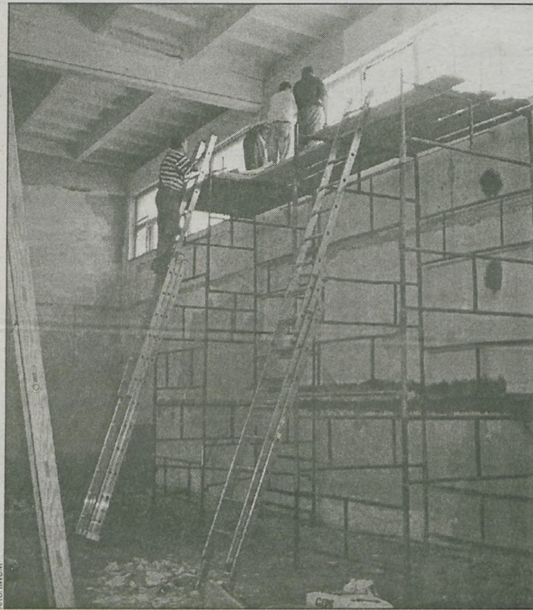
W sali ZSP nr 1 wymieniono okna
