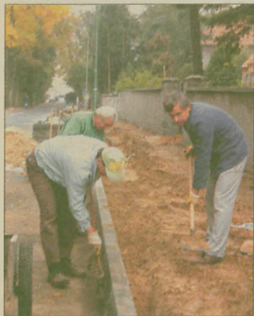
REMONT kapitalny chodników przeprowadzony został m.in. na ul. Mickiewicza w Żerkowie
