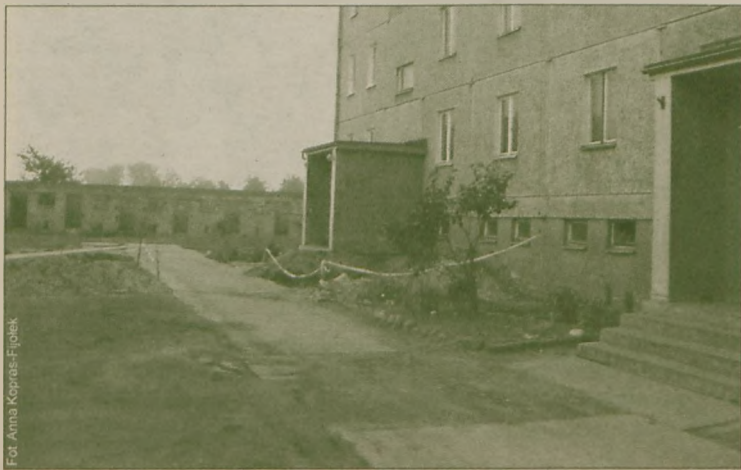
MIESZKAŃCY BLOKÓW w Tarcach są zdenerwowani przedłużającym się remontem kotłowni
