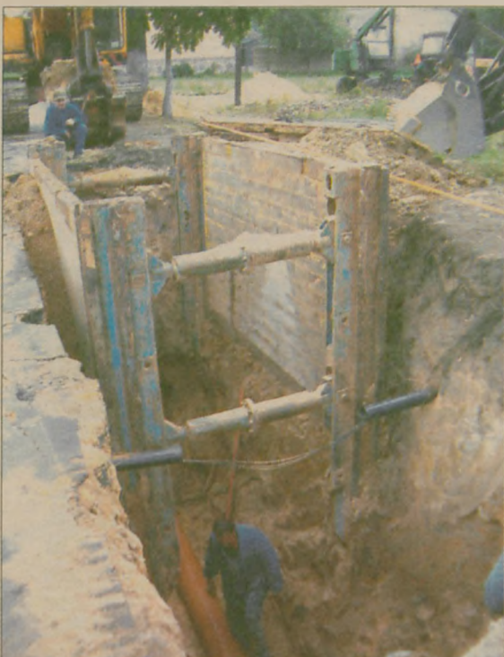
OBECNIE PRACE KANALIZACYJNE prowadzone są w Golinie (na zdjęciu), Cielczy i Roszkowie
