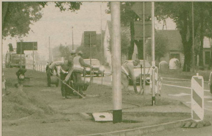
MONTAŻ sygnalizacji rozpoczęło we wtorek 30 września. Światła zostały już uruchomione
