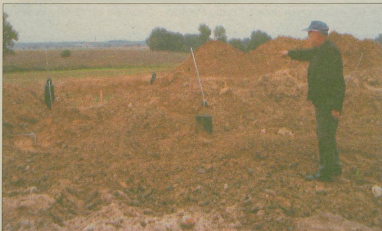
EDMUND KOWALCZYK wskazuje miejsce, w którym stanie słup linii wysokiego napięcia w Noskowie
