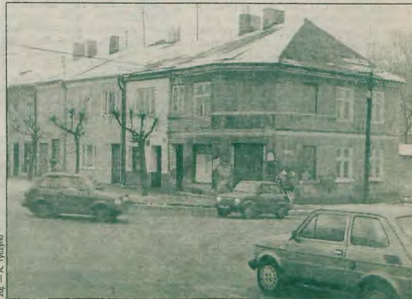
Trwają negocjacje z właścicielami budynków przeznaczonych do rozebrania
