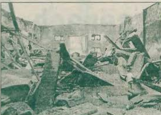
Magazyn został doszczętnie zniszczony
