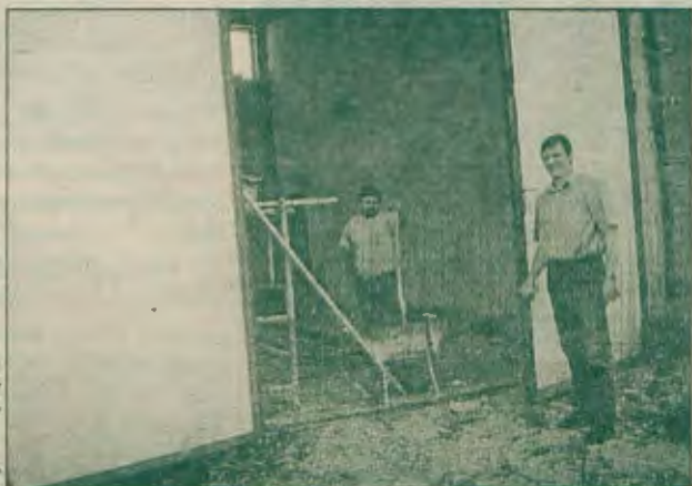
Kierownik Wojciech Targowski codziennie dogląda postępu prac na budowie
