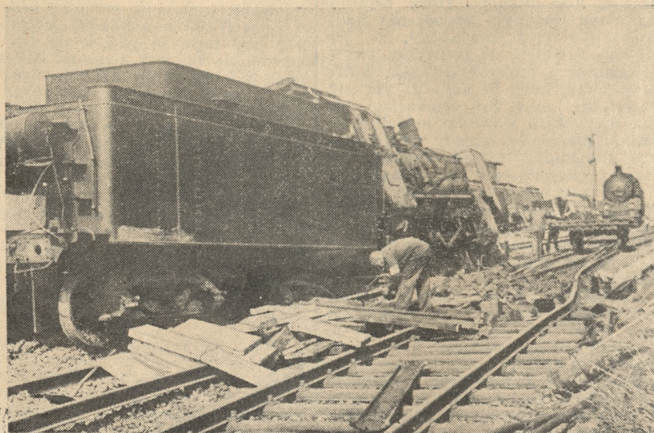
NA MIEJSCU KATASTROFY KOLEJOWEJ W NADRENI
