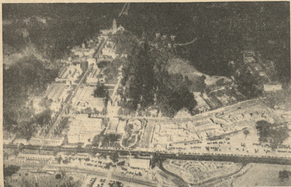
Zdjęcie nocne dokonane w San Diego aparaturą Fairchild z wysokości 1.500 m. przy oświetleniu bombą o sile dwóch miliardów świec.
