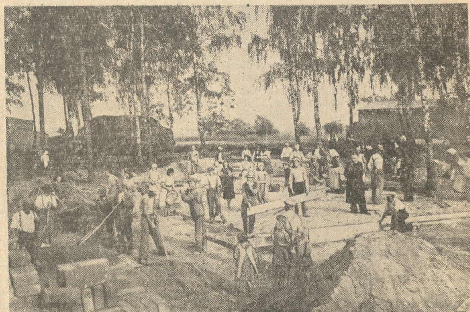
Fragment z prac wstępnych przy budowie kościoła w Brodziszewie. Pracują tam bezinteresownie wszyscy mieszkańcy wioski, mężczyźni, kobiety, nawet małe dzieci pomagają przy budowie Domu Bożego.
