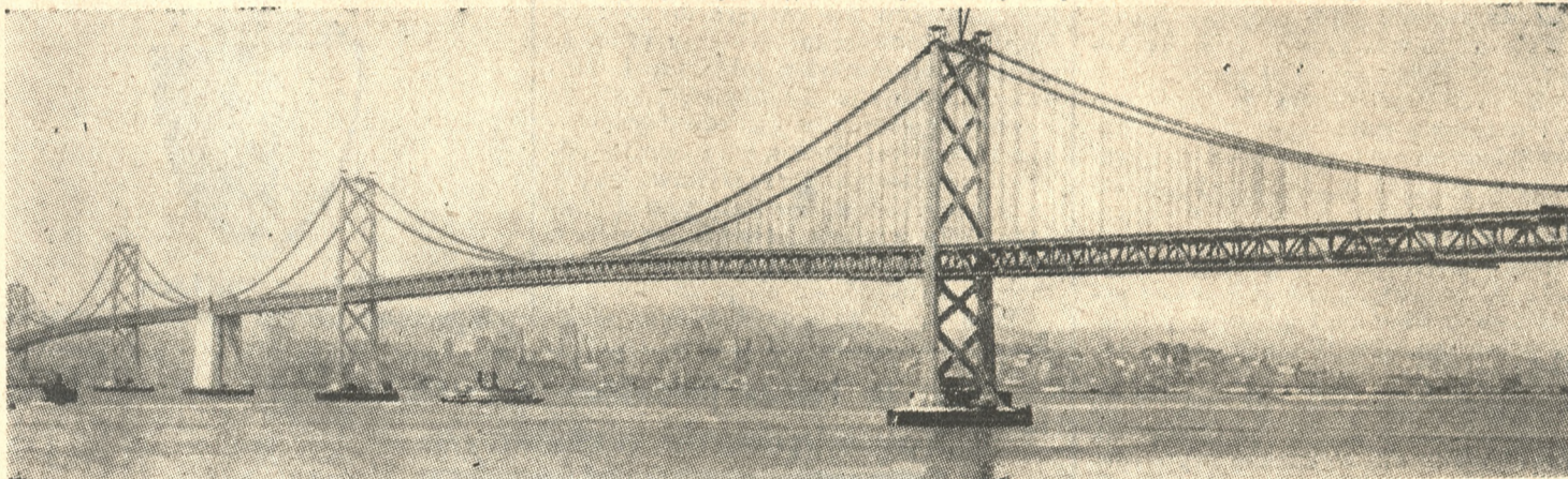
Most wiszący łączący San Francisco z Oaklandem poprzez zatokę San Francisco. Jest to najdłuższa konstrukcja mostowa na świecie. Największa rozpiętość przęsła wynosi tylko 900 m.
