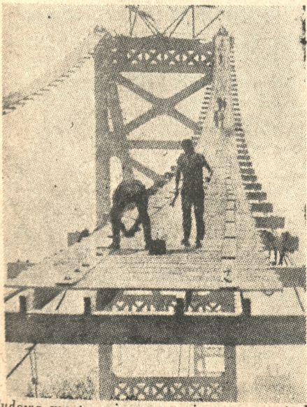
Budowa mostu wiszącego nie wymaga żadnych rusztowań. Na dwóch linach pomocniczych układa się chodnik z desek, który tworzy podstawę do dalszych prac nad konstrukcją mostu.
