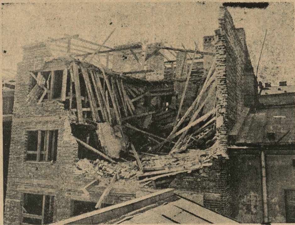
Widok miejsca katastrofy budowlanej przy ul. Litewskiej 10 w Warszawie, gdzie od podwórza zawalili się dwa piętra budowanego domu mieszkalnego. Przyczyną katastrofy był kiepski materiał budowlany. (Fot. J. Ryś)
