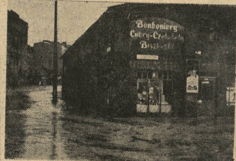
Ulice Gdyni po gwałtownej burzy z oberwaniem chmury.
