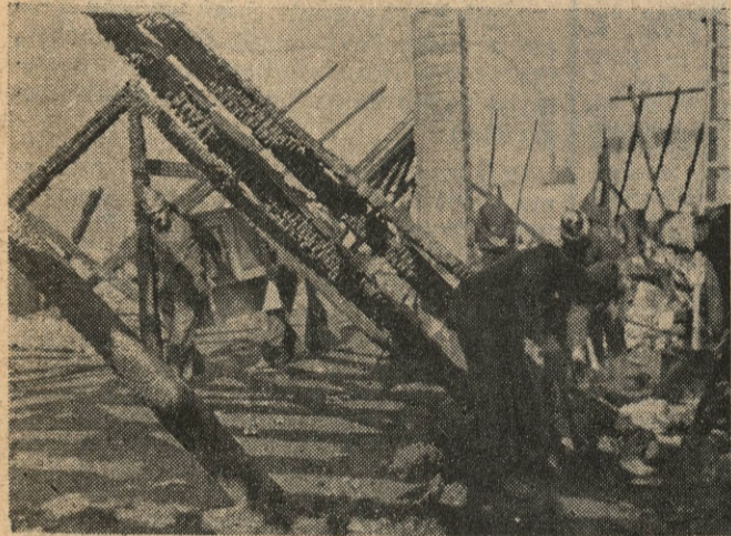
Spalone wiązanie dachu gmachu przy Al. Marcinkowskiego nr 13
