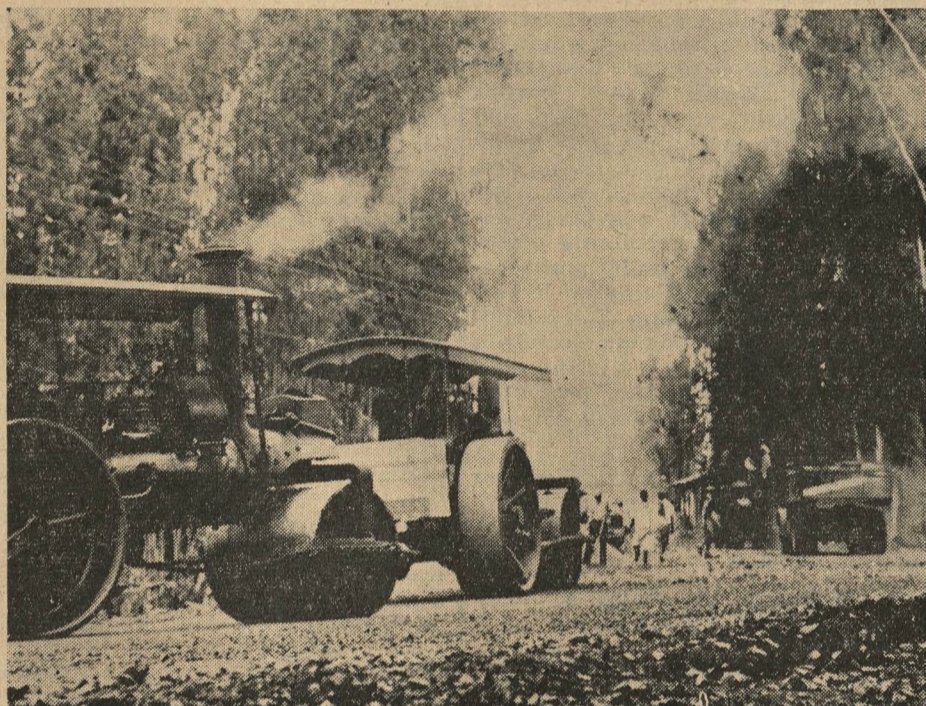
W Abisynii wreszcie ożywna praca nad budową autostrad. Na zdjęciu widzimy budowę szosy w prowincji Laghix.
