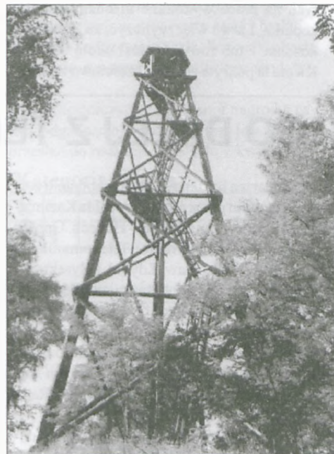
Stara, drewniana wieża obserwacyjna - jedyna na terenie gminy Wronki - stoi jeszcze, chociaż bezużytecznie. Po remoncie mogłaby być cudowną atrakcją dla turystów.
