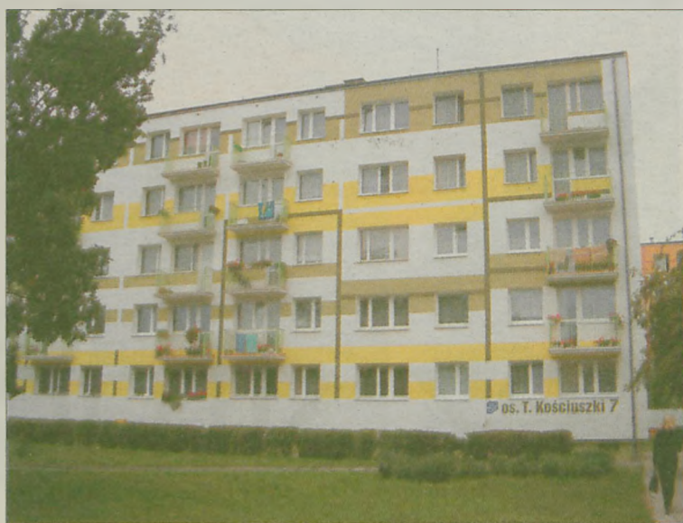
PO OCIEPLENIU BLOKÓW spółdzielnia oszczędza na ogrzewaniu ok. 30 % wcześniejszych kosztów
