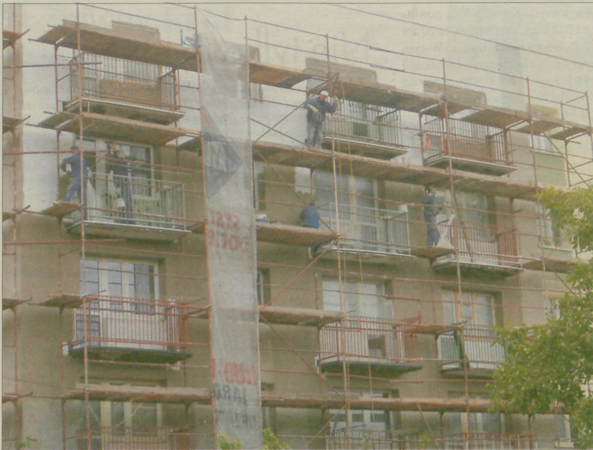
AKTUALNIE ROBOTY TRWAJĄ m.in. przy ul. Moniuszki 38
