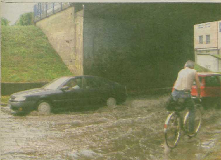
WYSTARCZYŁO KILKA MINUT ulewnego deszczu, aby pod mostami na ul. Niepodległości utworzyło się wielkie bajoro
