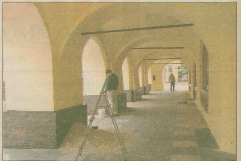
TRZYOSOBOWA BRYGADA pracowników interwencyjnych odmalowała podcienia ratusza
