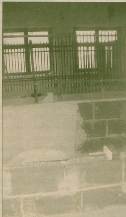
PRACE MURARSKIE wykonane zostały w również w schronisku dla zwierząt w Radlinie
