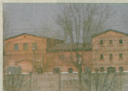
PO DAWNYCH PGR-ACH pozostały tylko niszczące budynki
