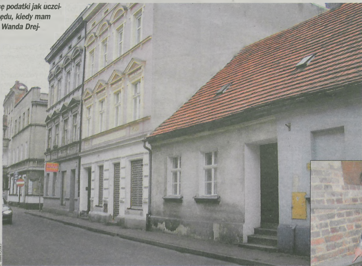
Czy uszczelnienie piwnicy w budynku przy Kaliskiej 6 (ten pierwszy, niski) miało wpływ na pojawienie się wody w piwnicy sąsiadów?
