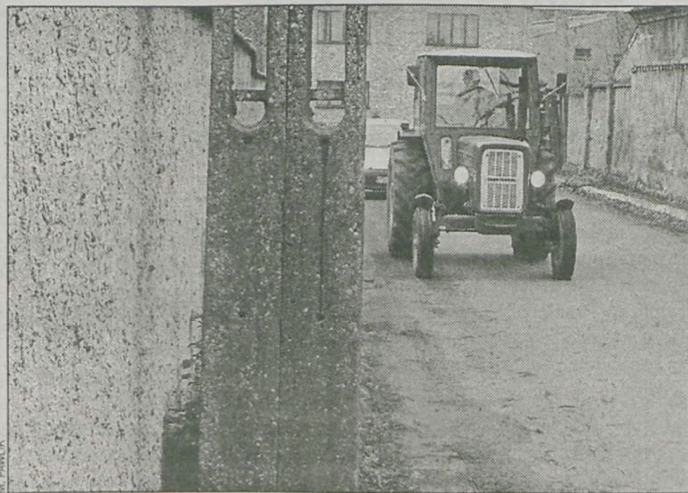
Słup nie powinien stać tak blisko jezdni
