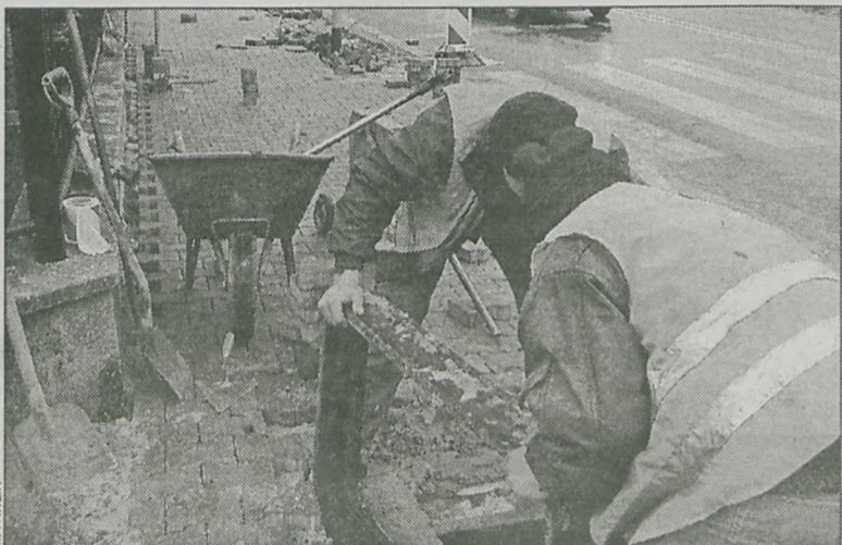
Już niedługo będzie tu kostka brukowa
