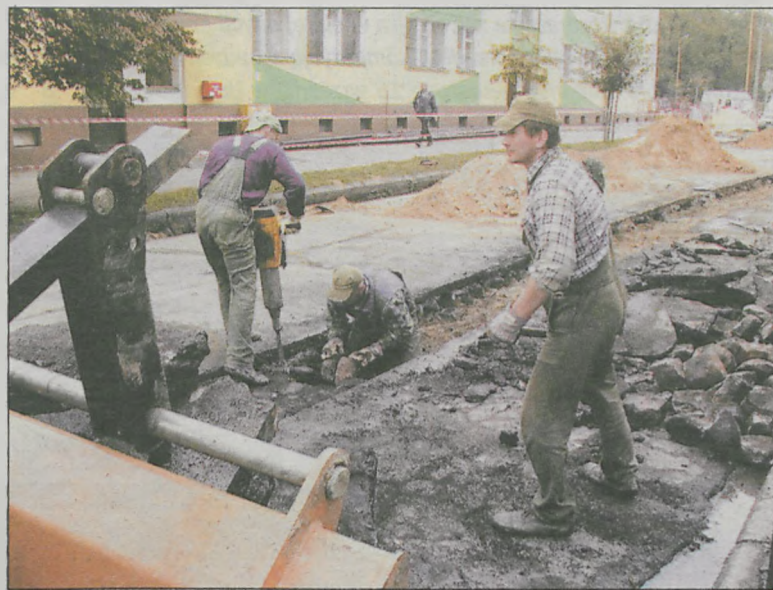
Na ul. Floriańskiej wymieniana jest sieć wodociągowa...
