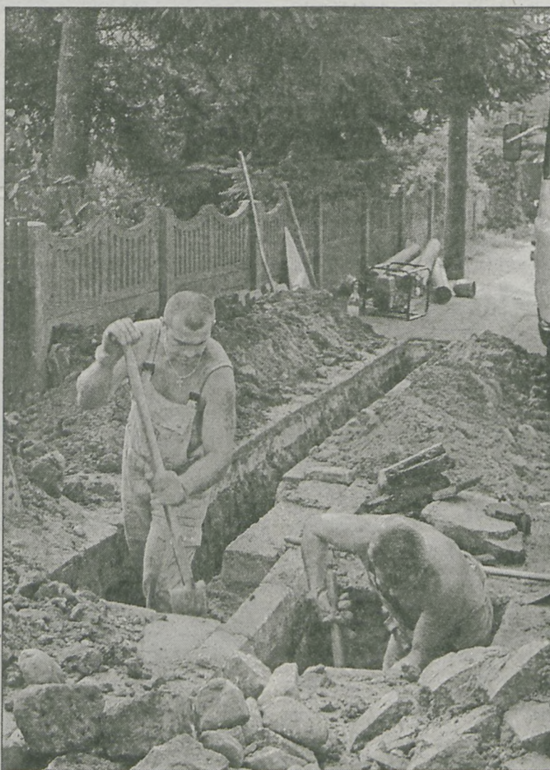
Drogowcy zakładają kratki kanalizacyjne na ul. Osadniczej
