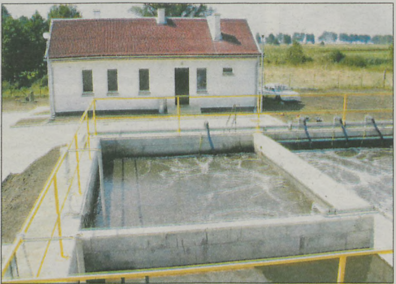
W oczyszczalni trwa rozruch technologiczny
