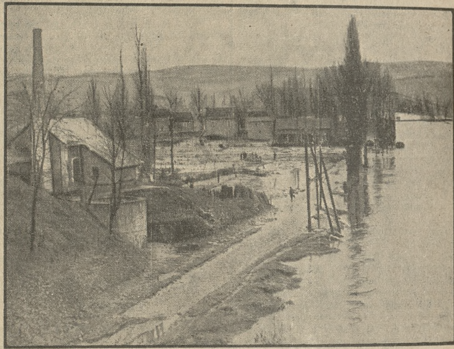
Obrazek z nawiedzonych powodzią okolic Francji. Woda unieruchomiła zakład elektryczny.
