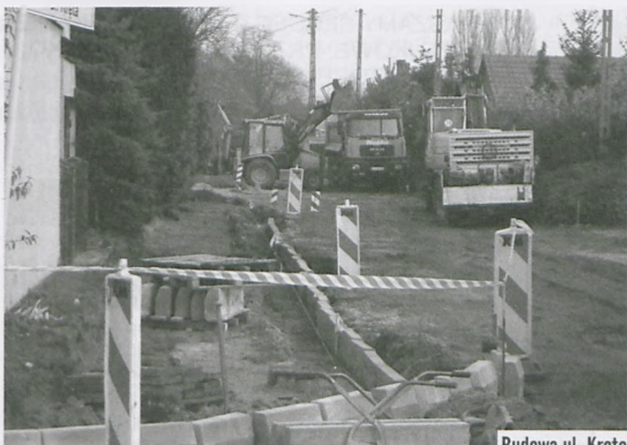
Budowa ul. Krętej
