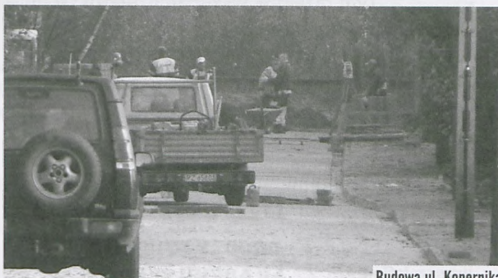
Budowa ul. Kopernika
