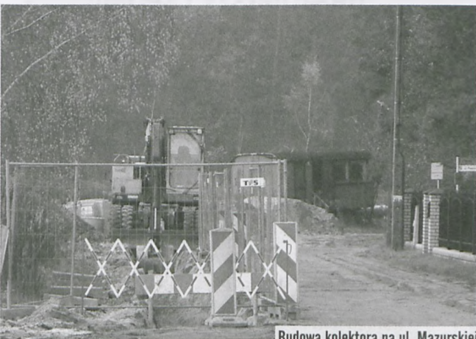
Budowa kolektora na ul. Mazurskiej
