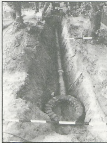
Na ukończeniu prace przy kanalizacji deszczowej w ulicy Szkolnej
