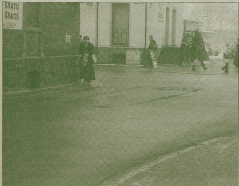
Nawierzchnia na ulicy Paderewskiego naprawiona zostanie wiosną. Gmina nie poniesie z tego tytułu kosztów
