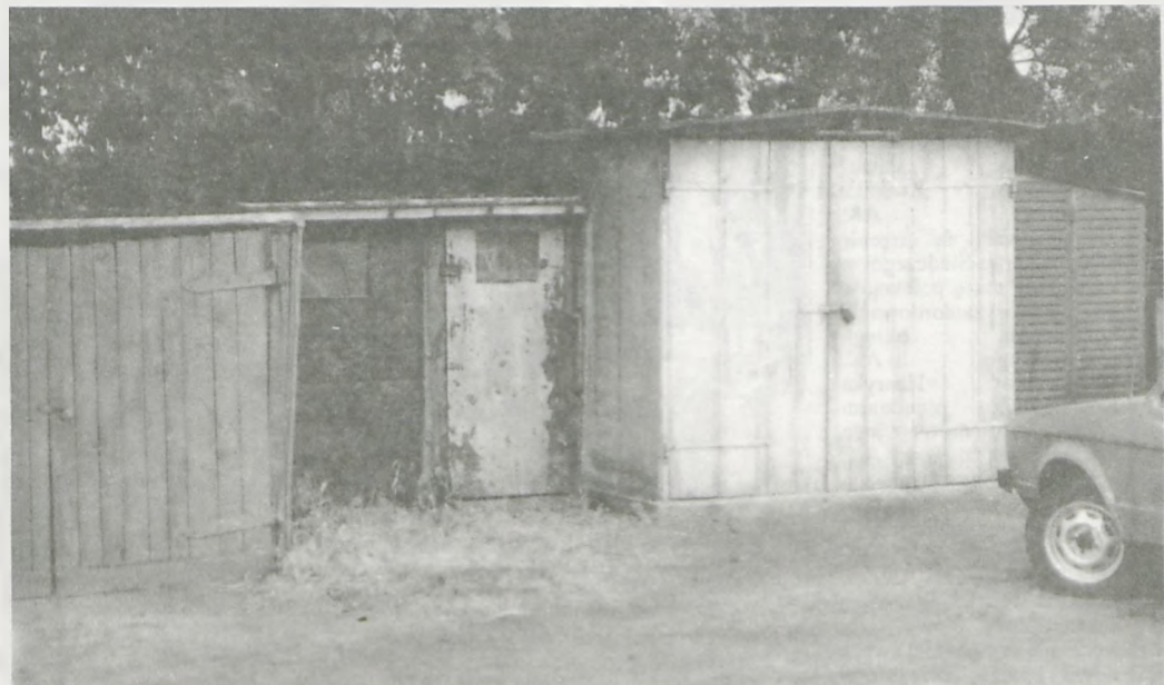
A oto niektóre przedmioty sporu, na zapleczu budynków zakładowych przy ul. Armii Poznań.
