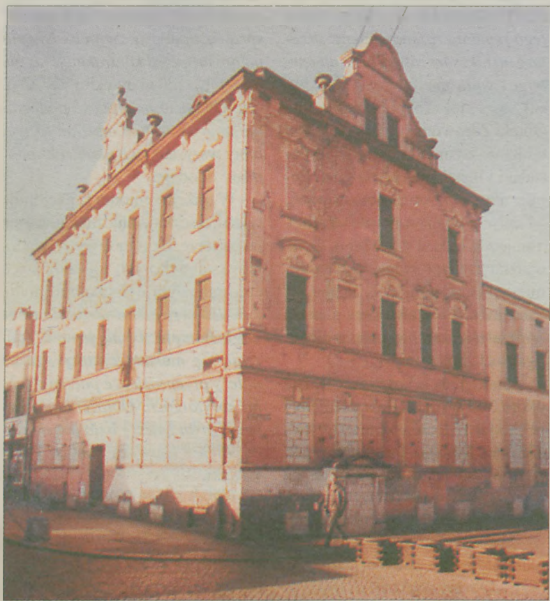
Plany dotyczące nowej siedziby jarocińskiego banku PKO są imponujące. Tymczasem obiekt nadal straszy na naszym rynku
