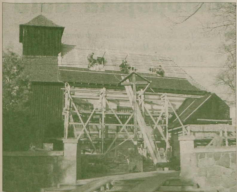
Obecnie sześciuosobowa ekipa górali z Nowego Targu pracuje przy dachu krytym gontem. Kościół w Noskowie wraca już do swojego poprzedniego wyglądu
