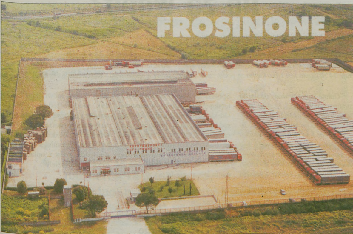
Baza przeładunkowa firmy Toti. Podobne obiekty powinny powstać w Jarocinie
