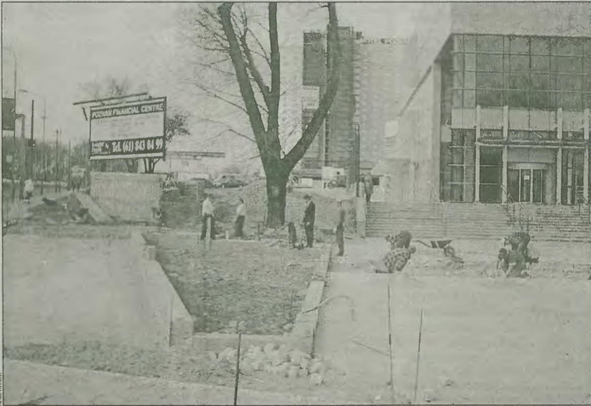
W kwietniu i maju zakład wykonywał prace na placu przy Poznańskim Centrum Finansowym
