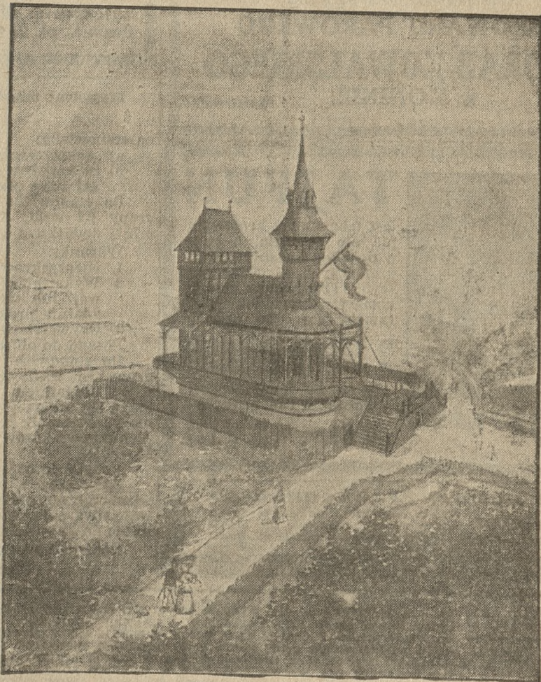
Pawilon restauracyjny na przemysłowo-rzemieślniczej wystawie w Poznaniu w roku 1895; projekt wykonał architekt F. A. Binder. Pawilon ten wzniesiony był mniej więcej w tym miejscu, gdzie dzisiaj znajduje się Collegium Minus.
